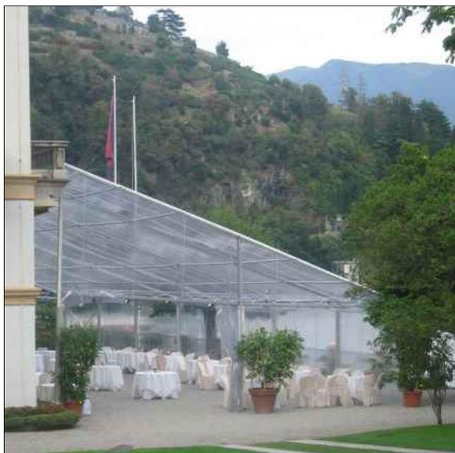
Struttura modulare costituita da portali a singola falda realizzati in alluminio e tamponamenti in pvc con reazione al fuoco cl.2.
