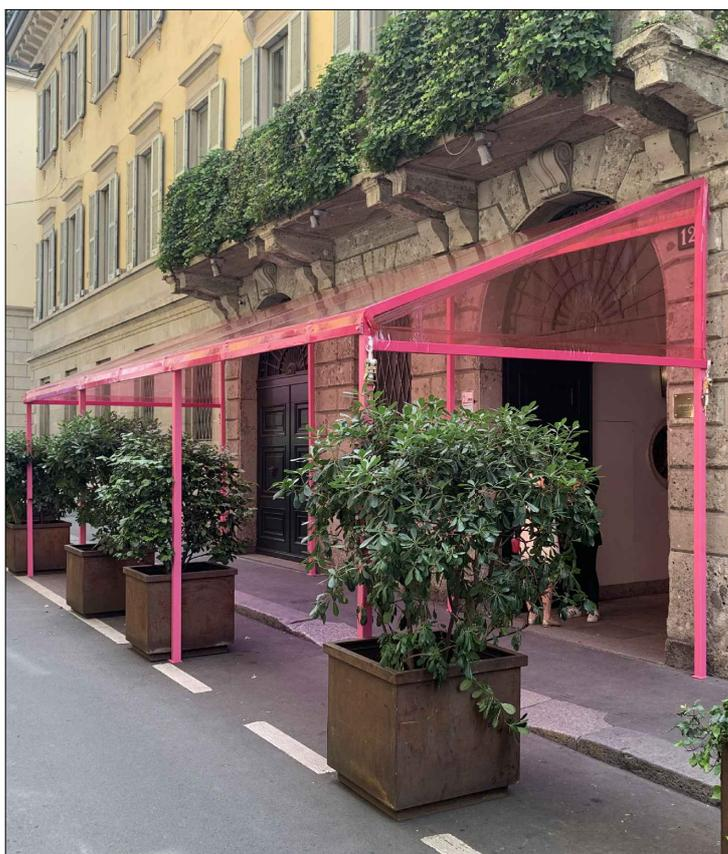
Struttura modulare costituita da portali a singola falda realizzati in alluminio e tamponamenti in pvc con reazione al fuoco cl.2.
